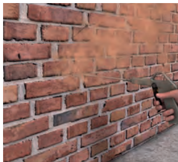
2 步骤2：吹除钻孔中的钻尘；
