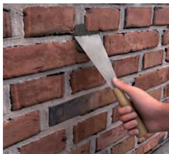
5 步骤5：在注射完成后，拔出注浆头，选用流动性好，无收缩的碧林®封孔清浆封孔；
