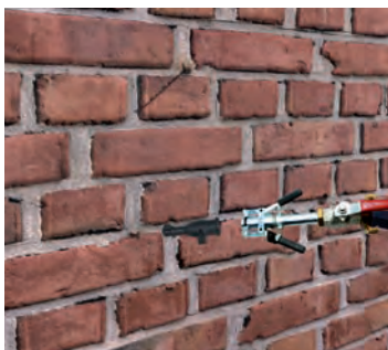
4 步骤4：加压注射具有德国WTA认证的可锁漏Kiesol 防水剂来达到防止毛细水上升的效果；
