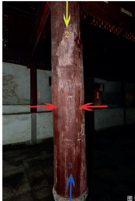
强度相对较高。现有资料显示 D4 为更换过的新木柱, 根据不同高度的波速情况来看, 木柱 D3 的波速与 D4 十分接近, 均在 1 600—1 800 m/s 之间, 所以可以推测 D3 也是更换过的新木柱。由于波在空气中的传播速度为 340 m/s, 低于在木材中的传播速度, 所以超声波在穿过带有空隙的木材时波速会明显降低。据此可初步判定, 波速相对新木柱较小的其余受检木柱年代久远且内部拼接已出现开裂。
