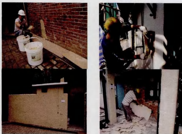
图 4 现场排盐灰浆施工、取样及接取过程
