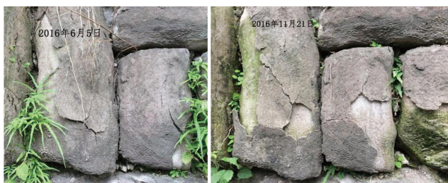
图9 采用所谓“防风化”处理的砂岩（左），在10余年后出现的无法修复的病害（右）
