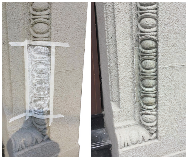
图 6 上海某历史建筑采用新型脱漆膏去除真石漆的效果
