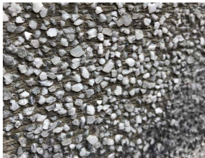
采用膏状除漆剂除去涂料以观测基层，少干预原有的材料
