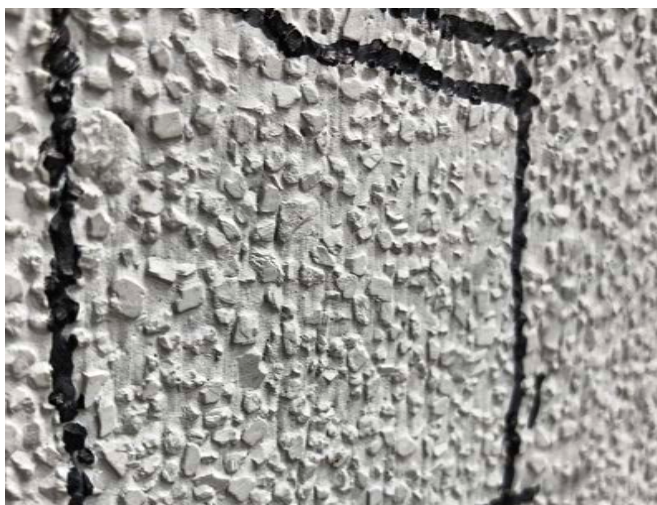
采用膏状除漆剂除去涂料以观测基层，少干预原有的材料
