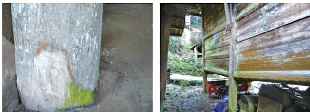
图2 木柱根部吸水出现腐朽、青苔(图片来源:作者自摄)
