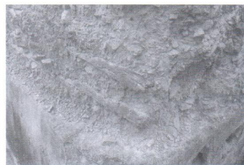
图5：夯土墙表皮风化
