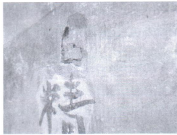
图 7: 原址保护石灰表皮人 为按压塌陷
