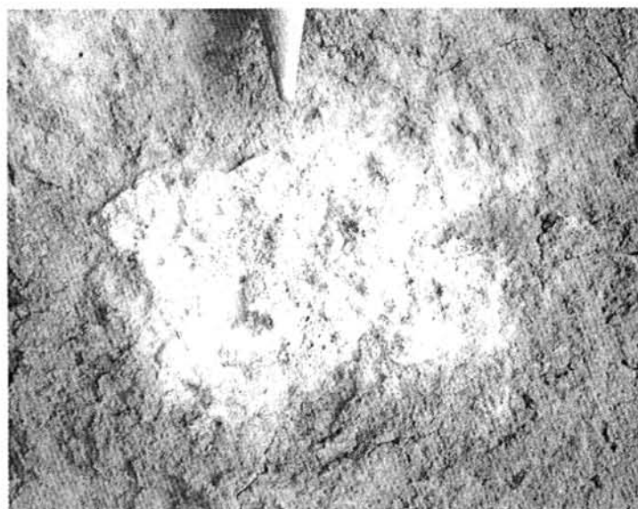
图4 固化后强度很高的生石灰块及周围的钙扩散,石灰与粘土 中水硬性组分发生的固化反应(平遥东城墙顶部防渗层)
