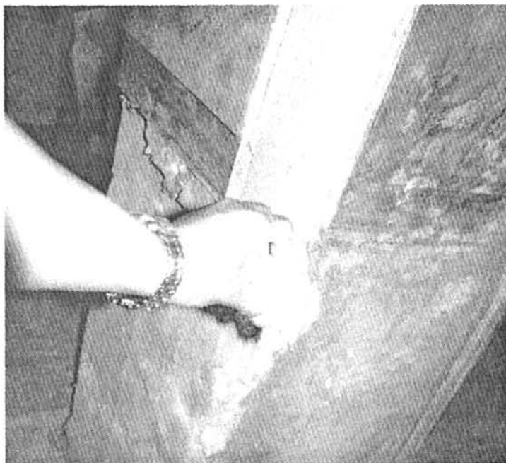
图3 强度可以与水泥砂浆相比的石灰砂浆粘结剂 (上海中实大厦,1920年前后)
