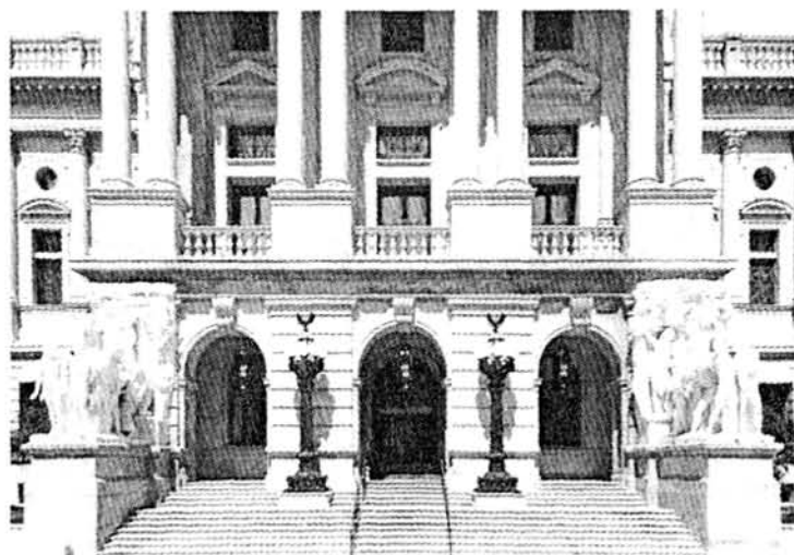
图 6 美国宾州州政府前的大理石雕刻, 碳酸盐大理石开裂为主要病害, 2000 年开始采用石灰类材料粘结加固
