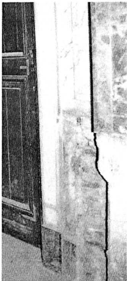
图2 上海北京东路中实大厦采用石灰粘结的大理石（1920年前后）
