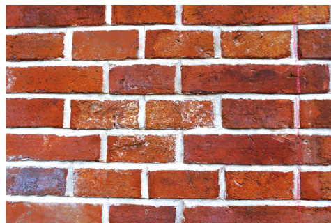
图2a 勾缝修旧如初,剔除原勾缝,采用原材料原工艺
