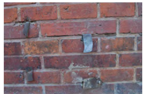
图3b 后期修复的平缝
