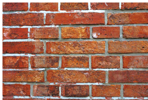
图2b 勾缝修旧如故,保持勾缝现状,局部修补
