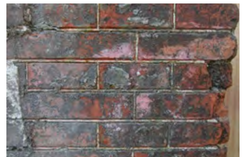
图3a 2014年上海总商会主楼外立面残留的元宝缝
