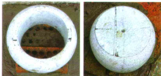
(a)木柱D采用空心石材柱础 (b)木柱E采用实心石材柱础
