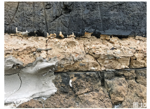
图10 明中都城墙双缝(图片来源:戴仕炳摄影)
