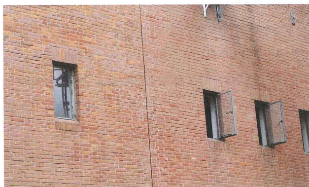
图8 上海某历史建筑同一朝向立面采用相同修复材料在修缮后10年不同的效果，左侧立面修复工期赶，右侧立面修复工期合理 图片由戴仕炳提供
