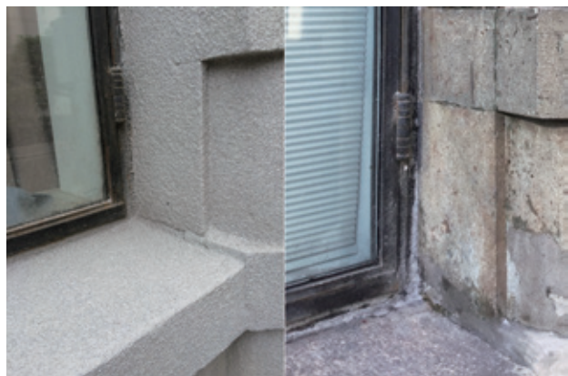
上海市广东路102号喷涂的真石漆采用新型脱漆膏去除后的效果（右侧为喷涂真石漆）
