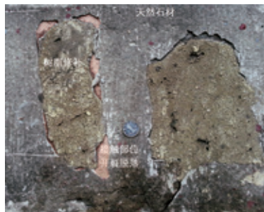
采用合成树脂配置的修补剂在不到3年时间内对天然石材造成的二次破坏（摄影：戴仕炳）
