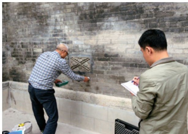
微波法无损测定砖石砌体含水率
