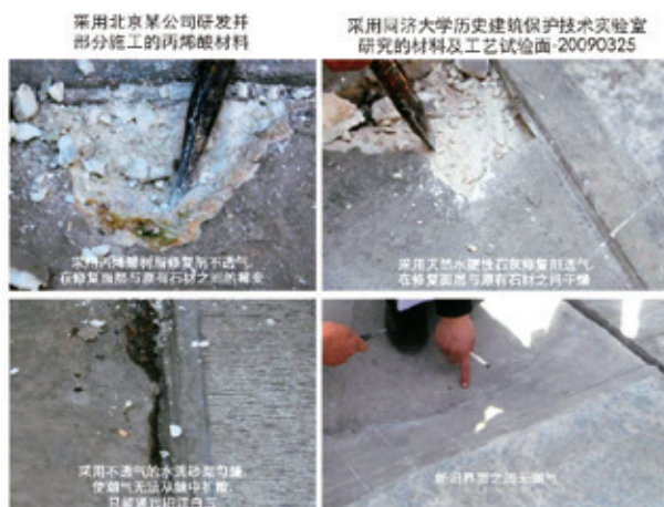
天然水硬石灰修补剂及石灰嵌缝在天安门金水桥桥面修复中的应用
